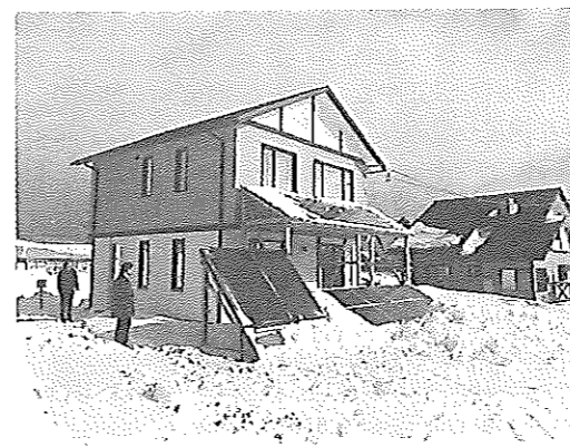
展示場：セミナーハウス（地中熱ヒートポンプ、太陽熱利用、太陽光発電の組合せ）
